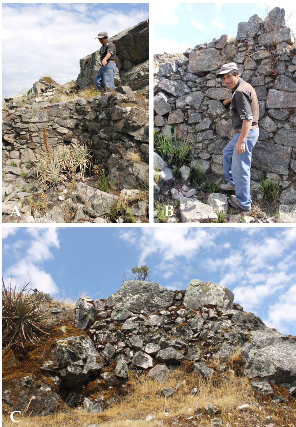
Fig. 9. A. Sector 1: Detalle de otro recinto, con uno de sus muros aprovechando parte de la “pared” natural del afloramiento. B. Detalle de las técnicas constructivas de los muros. C. Otra vista de detalle de las técnicas constructivas.
