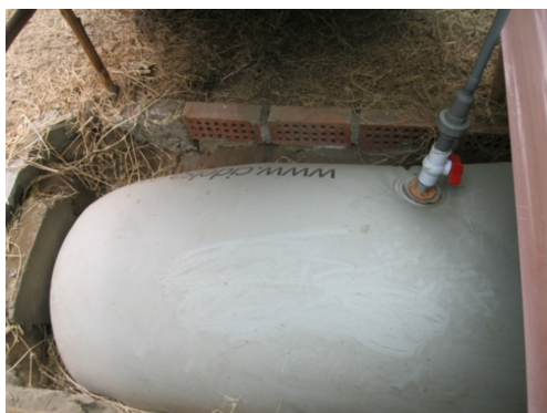
Fig. 5. a.) Válvula de salida de biogás del biodigestor. b). Gasómetro
