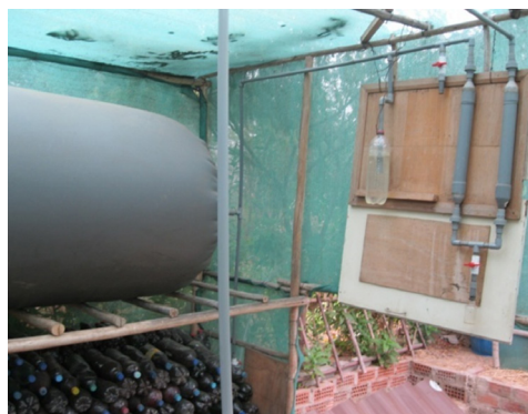
Fig. 5. a.) Válvula de salida de biogás del biodigestor. b). Gasómetro
